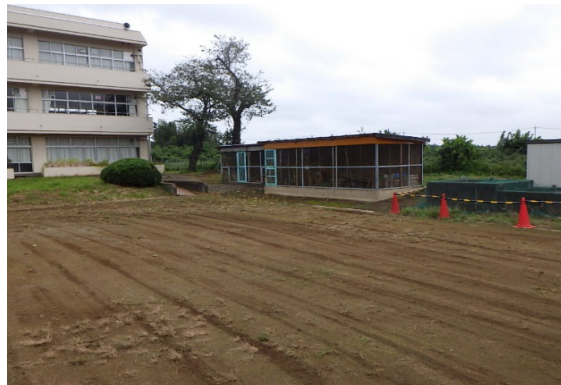
H鋼下にも、草や石が溜まるので一周毎に撤去
