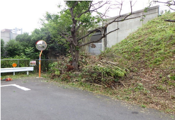
高速道路高架橋法面草刈り作業
