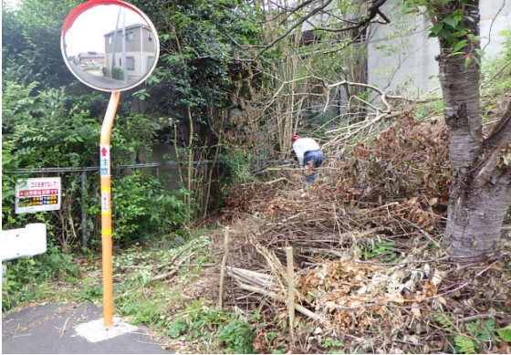
高速道路高架橋法面雑木集積
