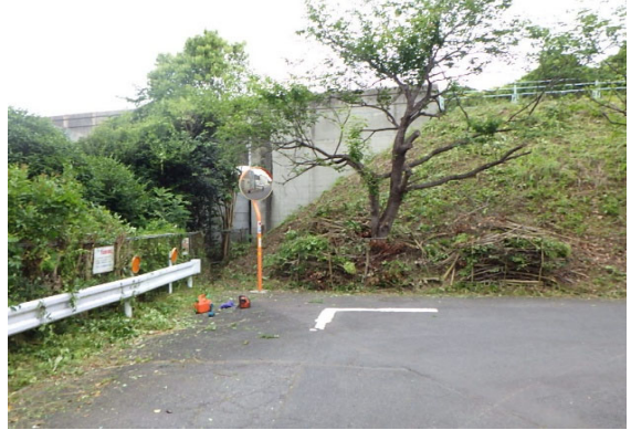
高速道路高架橋法面雑木集積
