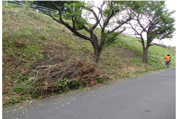
高速道路高架橋法面草刈り作業
