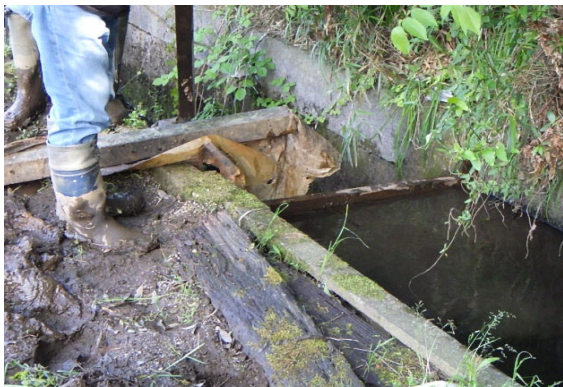
道路寄り用水路付近にある排水口を塩ビ管で止水
