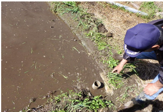
道路寄り用水路付近にある排水口を塩ビ管で止水
