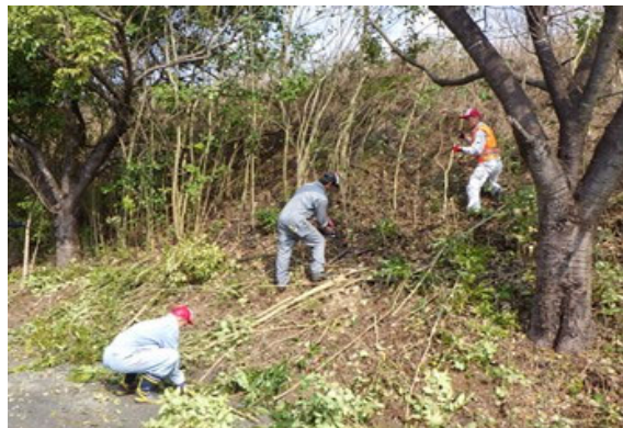
県道279号線の高速道路高架橋法面雑木伐採
