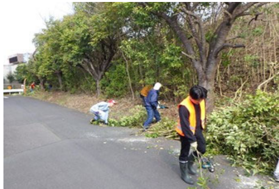
県道279号線の高速道路高架橋法面雑木集積作業
