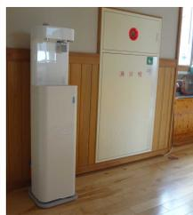
「ナノスタンド」は、サーバー内で水道水から JIS 規格の 12 項目の不純物を除去し、おいしい水をつくりだします。自宅から水筒だけ(もしくは水を入れた水筒)を持参し、登校後に給水することも可能です。登校時の荷物軽減にもつながります。
